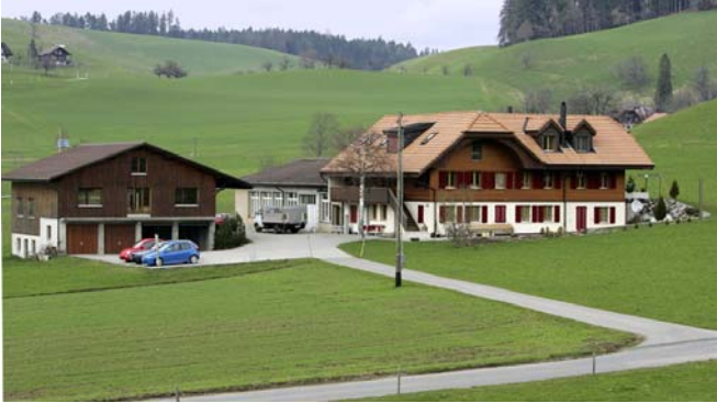
Der Firmensitz der Grunder AG in der Hutmatt 168 in Utzigen. Optimale Infrastruktur mit Wohnhaus, Büros und Werkstätten.
